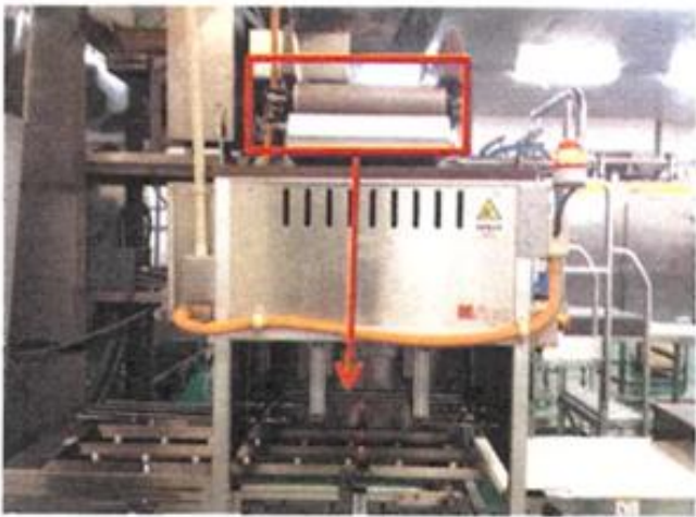
【混入原因となった場所 米飯輸送コンベア】
